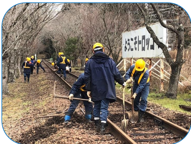
【トロッコ亀岡駅構内マクラギ交換】
