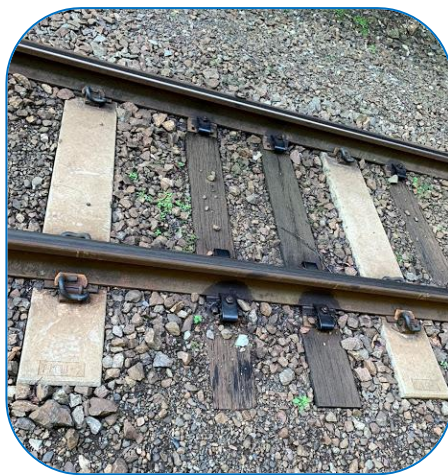
【トンネルマクラギ 1/3 コンクリート化】
